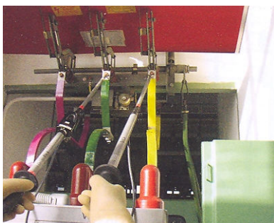
Slika 2: Ugotovitev breznapetostnega stanja z dvojnimi indikatorjem
