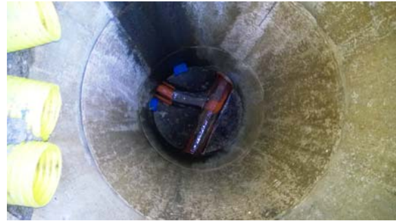
Slika 6: Revizijski jašek U7 (priključki drenažnih cevi v dnu jaška)
