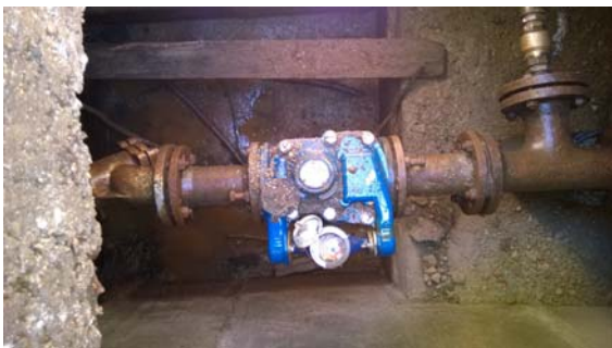
Slika 7: Revizijski jašek za vodomer DN80/20 za zdravstveni dom
