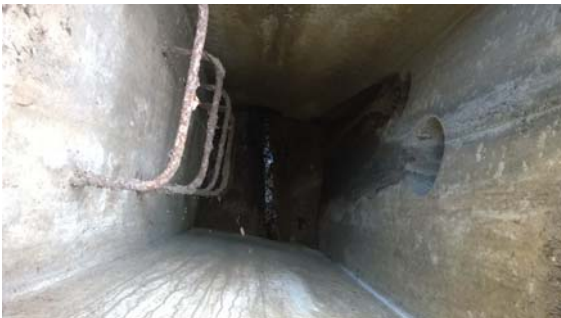
Slika 3: Revizijski jašek na fekalnem priključku zdravstvenega doma (globina H=5,27m').
