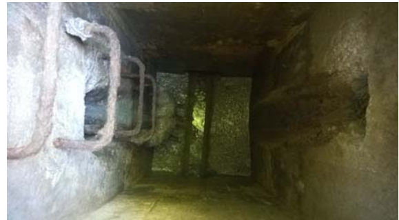
Slika 2: Revizijski jašek L-2 (globina h=3,4m')
