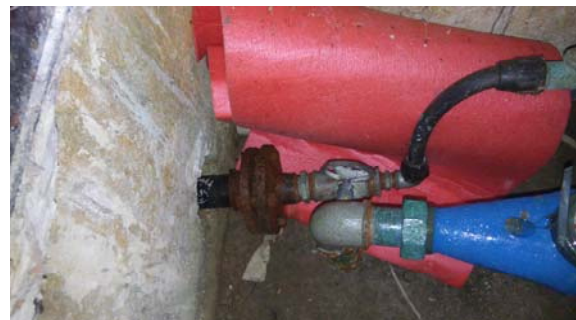
Slika 8: Revizijski jašek za vodomer DN25 za stanovanjski objekt h.št. 8
