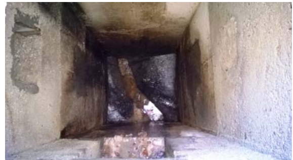
Slika 2: Revizijski jašek L-2 (globina h=3,4m')
