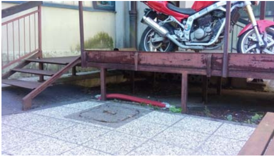
Slika 5: Revizijski jašek U-7 ob vhodu v stanovanjski objekt h.št. 8
